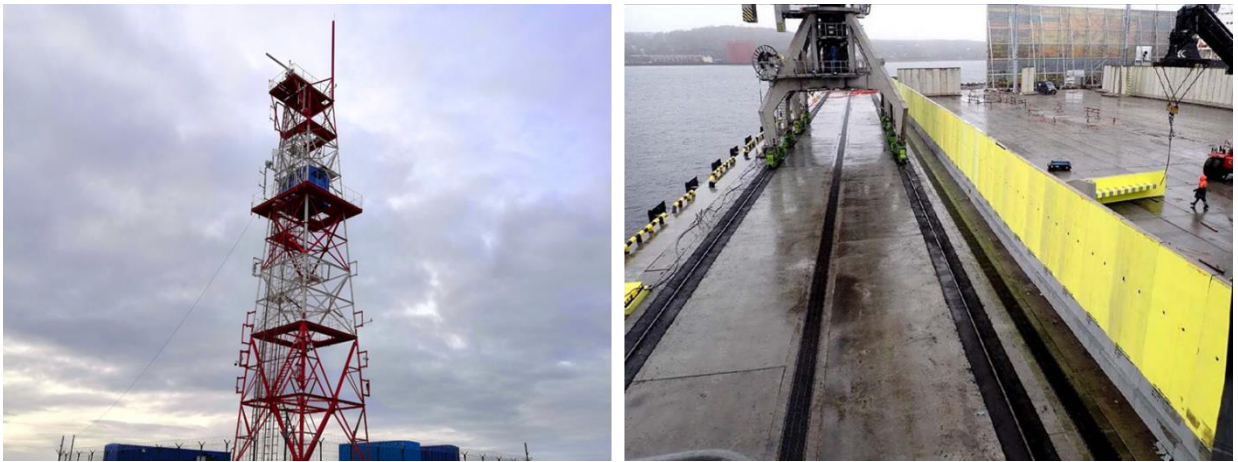
Рисунок 11.23 - Автоматизированный радиотехнический пост «Ура-губа» (справа). Причал № 2 в морском порту Мурманск (слева)
